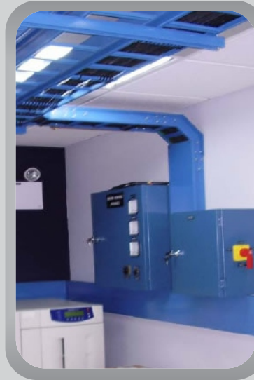
INSTALACIÓN DE CANALETAS
